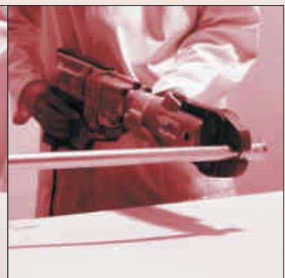
Obrázky 22 - 23 Prevedenie zalisovania spoja
